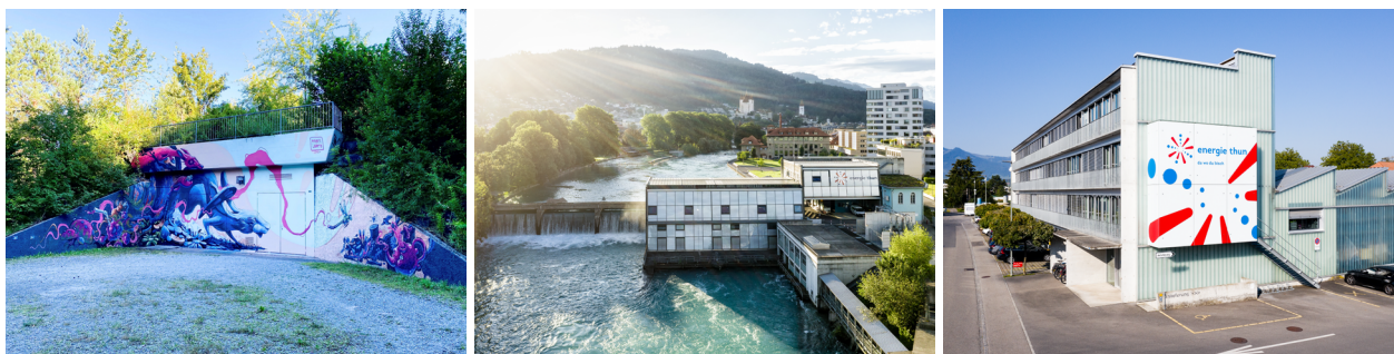
Figure 1: La station de pompage des eaux souterraines de Lerchenfeld, les usines Aarewerke Thun et le bâtiment d'exploitation sont tous soumis à la convention d'objectifs.
