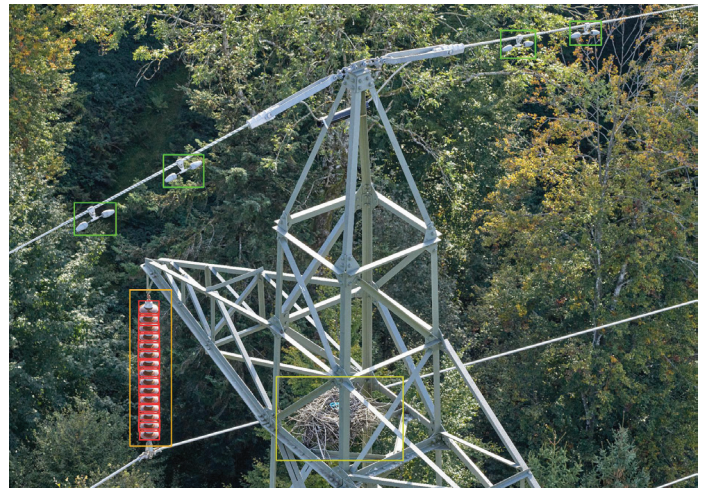
Les programmes de détection des défauts peuvent détecter les isolateurs, mais aussi les amortisseurs de vibrations (en vert) et les nids d'oiseaux (en jaune). Photo: Swissgrid
