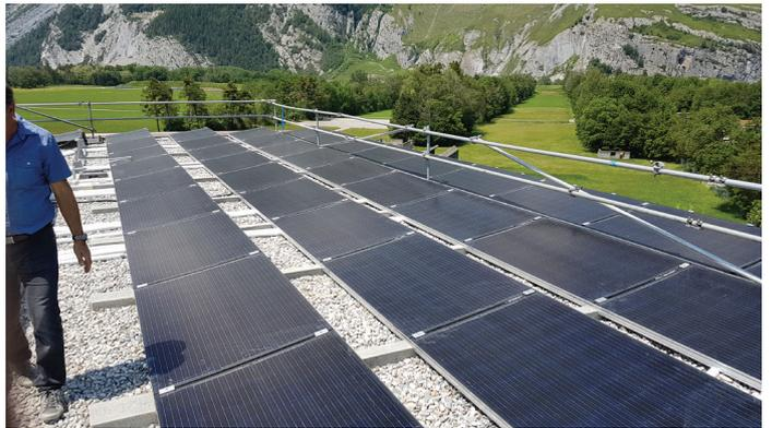
Les modules PVT à double vitrage produisent de l'électricité et de la chaleur, mais ils sont aussi utilisés pour le refroidissement du bâtiment. Le système PVT est optimisé en cas de besoin en refroidissement. S'il était optimisé pour la production de chaleur, il pourrait permettre d'obtenir environ 20 fois plus de chaleur. Photo: SPF/Vassella
