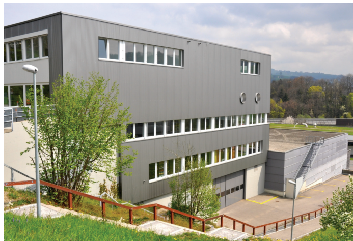
Construit en 1981 et rénové en 2013, cet immeuble de bureaux et de commerces à Saint-Gall a été équipé en 2023 d'une pompe à chaleur à basse course qui fournit de l'eau de chauffage à 26 degrés. Huit sondes géothermiques d'une profondeur de 280 m sont utilisées comme source de chaleur ou pour le refroidissement du bâtiment. La pompe à chaleur fonctionne avec un COP de 10 ou supérieur. Le chauffage de 100 m 2 de surface de bâtiment ne nécessite plus que la même quantité d'électricité qu'une ampoule de 40 watts consommait autrefois, a expliqué Beat Wellig de la Haute école de Lucerne pour établir une comparaison claire. Graphique: Mettiss AG
