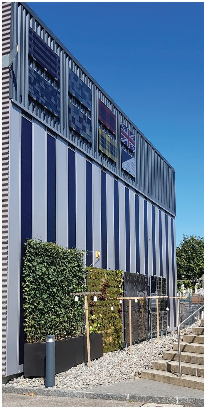
Quatre systèmes de façade ont été mesurés sur le campus de la HSLU (de gauche à droite): végétation au sol, végétation au mur, installation PV opaque, installation PV transparente. Photo: rapport final GreenPV
