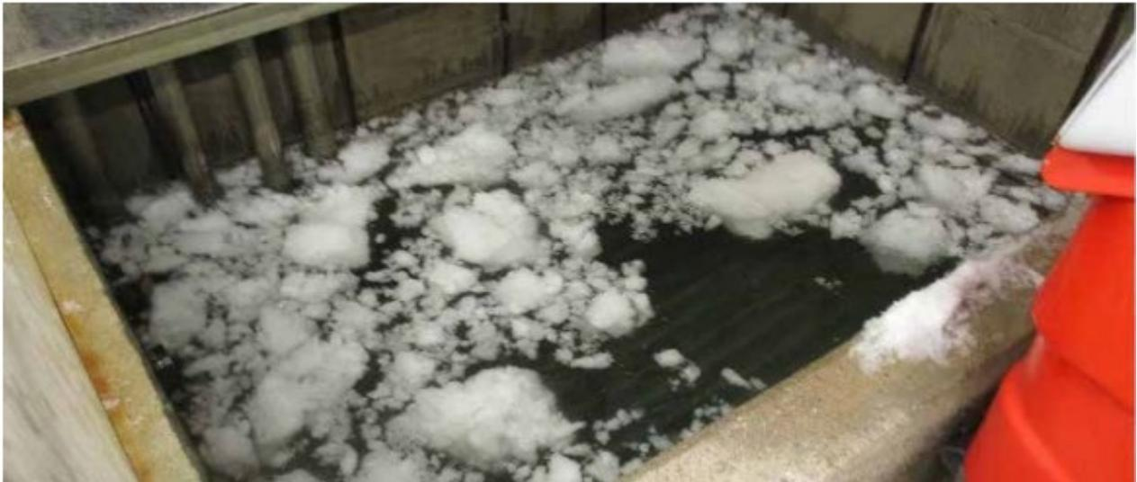
Figure 15: Puits de fonte de glace (source : IIFH)
