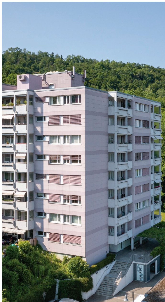
Un des deux blocs d'habitation du lotissement « Im Kehl » à Baden. Un système de chauffage par pompe à chaleur avec deux sources de chaleur y sera testé dans la pratique au cours des prochaines années. Photo: Lägern Wohnen
