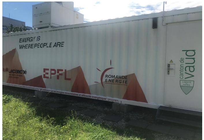
Cette batterie de stockage d'une capacité de 560 kWh a contribué à faire fonctionner les stations de recharge de l'EPFL en respectant les conditions du réseau. Photo : MESH4U
