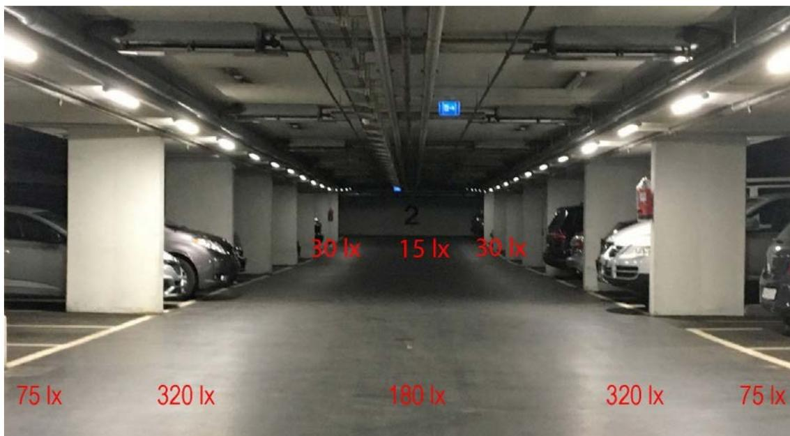
Figure 34 : Nouvel éclairage dans le garage Heuried (avec éclairage, lumière d'orientation à l'arrière)
