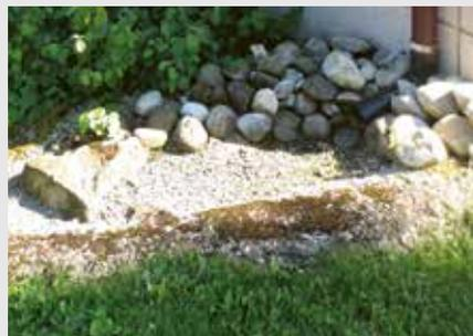
Illustration 10.4: Méthode simple pour maintenir l'eau de pluie à la surface: au lieu d'être évacuée directement dans les canalisations, elle est dirigée en surface vers une cuvette d'infiltration. (Source: Association suisse des professionnels de la protection des eaux)
