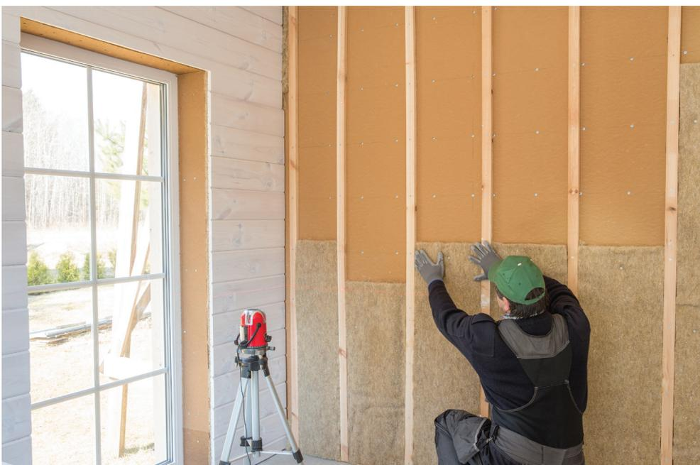
Isolation thermique avec des panneaux de fibres de bois et du chanvre naturel.
