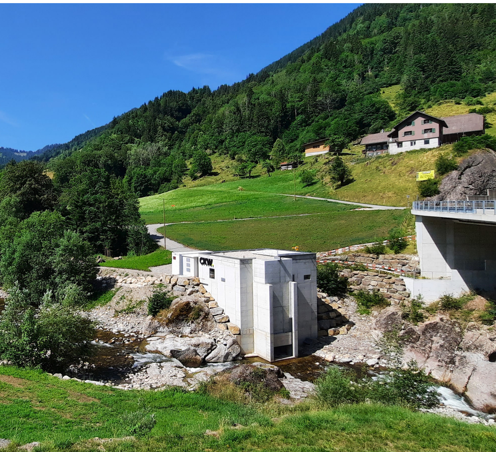
La centrale hydroélectrique de Waldemme, récemment achevée (© CKW)
