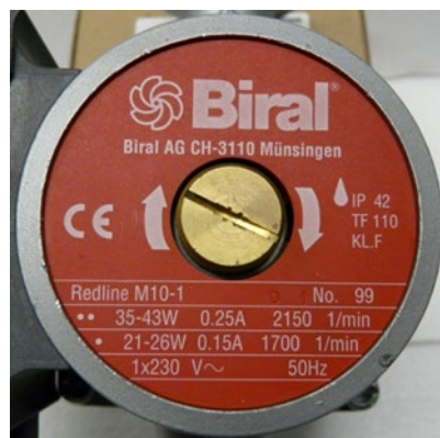
Figure 2 : Plaque signalétique de la pompe, source: Biral Redline M10-1
