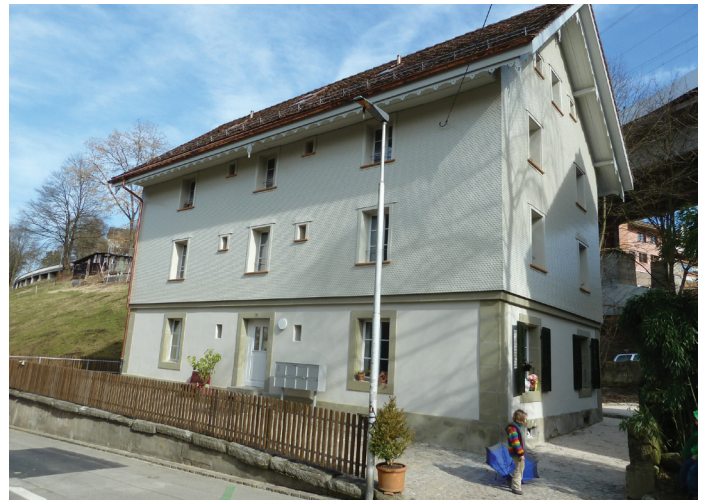
Depuis sa rénovation en 2013, cette maison de trois familles située dans le quartier de la Lorraine à Berne est alimentée en chaleur de chauffage et en eau chaude par une pompe à chaleur à sonde géothermique (13 kW). Photo: eicher+pauli
