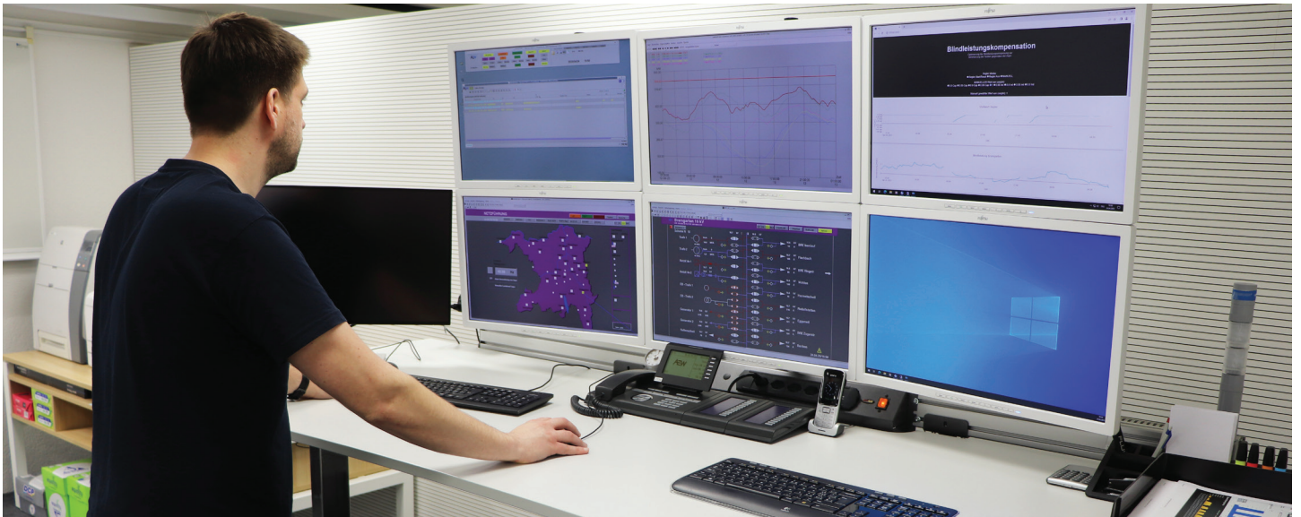
Patrick Linggi dirige le centre de conduite du réseau AEW à Aarau. L'écran en haut à droite représente la puissance réactive prélevée sur l'installation PV de Tägerig (AG). Photo: B. Vogel
