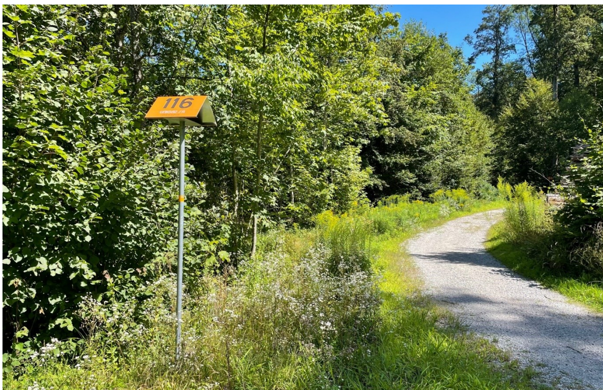
Marquage d'une conduite de gaz naturel
