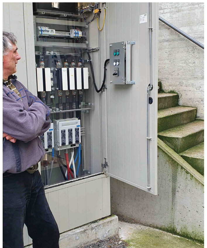
L'agriculteur Otto Wartmann à côté de l'installation qui a permis d'étudier l'alimentation électrique de secours au moyen d'énergies renouvelables dans la ferme « Holzhof ». Photo: Fleco Power
