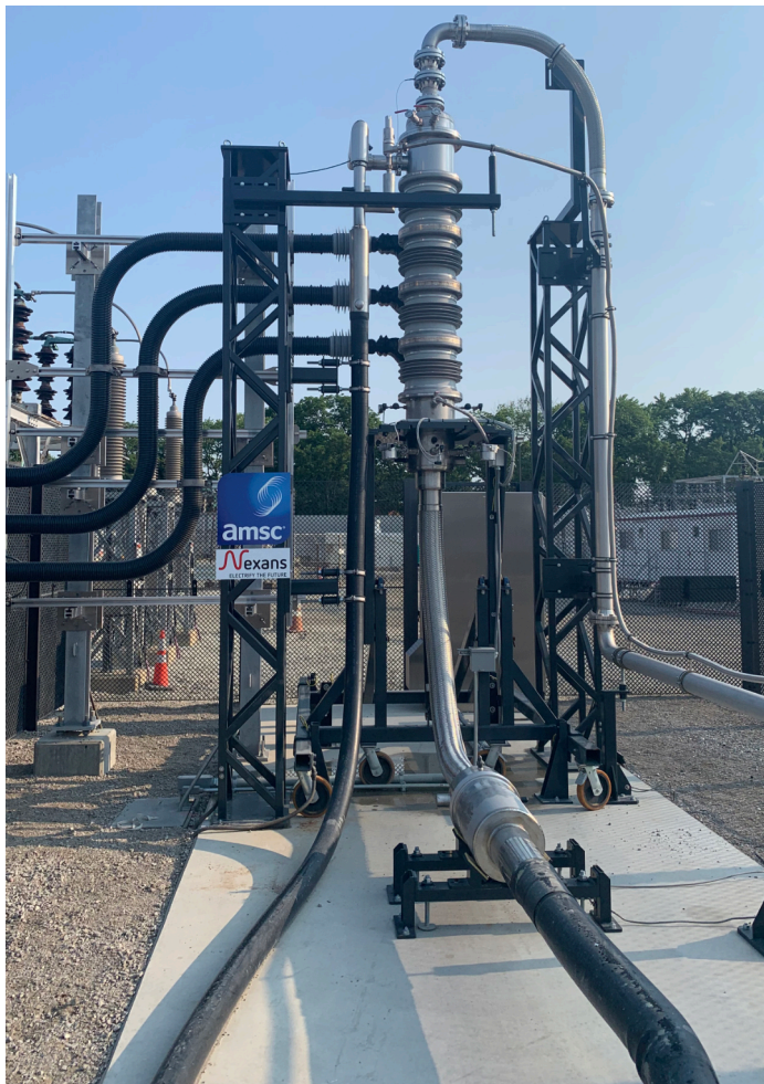
Photo du projet de câble HTS à Chicago, dans l'État américain de l'Illinois. Photo: AMSC
