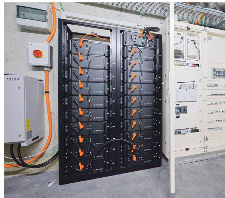
Cette imposante batterie stocke l'électricité solaire produite par le toit d'une école.
