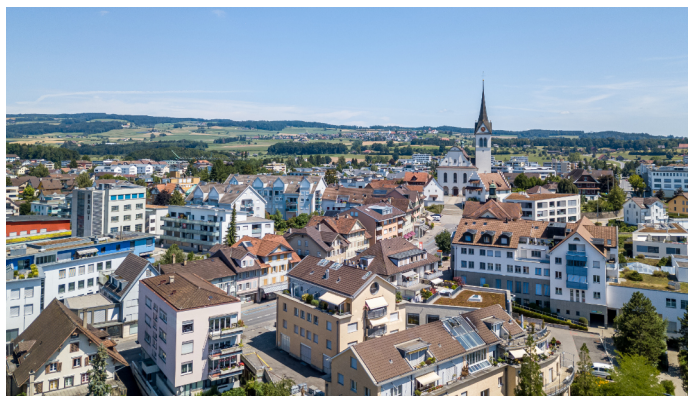
Le réseau de la société WWZ (auparavant: Wasserwerke Zug) de la Luzernerstrasse à Hochdorf (LU) fait office d'exemple pour un réseau électrique urbain. Le projet BFH-TI part du principe que la puissance des installations PV installées de ce réseau d'aujourd'hui 237 kWp, passera à 647 kWp en 2035. Photo: commune de Hochdorf
