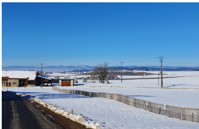
Le réseau de distribution du Groupe E à Haut de Fiaugères est un exemple de réseau électrique rural. Le projet BFH-TI part du principe que la puissance des installations PV installées de ce réseau d'aujourd'hui 32 kWp, passera à 362 kWp en 2035. Photo: Groupe E
