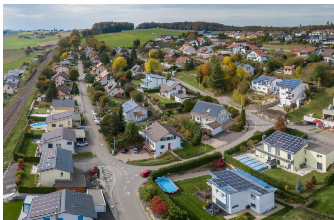
Le réseau de distribution du Groupe E à Neyruz est un exemple de réseau électrique suburbain. Le projet BFH-TI part du principe que la puissance des installations PV installées de ce réseau d'aujourd'hui 310 kWp, passera à 1320 kWp en 2035. Photo: STEMUTZ.COM
