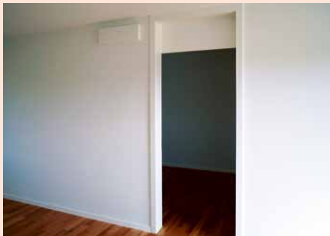
Figure 3.8: Situé au-dessus de la porte à gauche, l'élément actif de transfert d'air fait passer l'air de la chambre à coucher au séjour.
