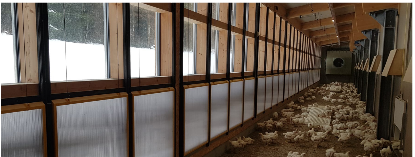
Poulailler à Zimmerwald (BE): en cas de basses températures, les coulisses du jardin d'hiver sont fermées. Tout au fond, on voit l'échangeur de chaleur de l'air d'alimentation, grâce auquel de l'air frais et préchauffé entre toujours dans le jardin d'hiver par le système en circuit fermé. Photo: BZG Guggisberg et Nussbaum
