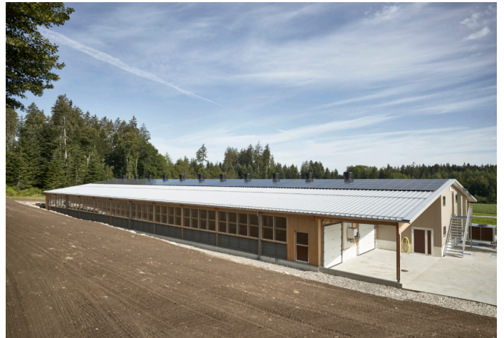
Vue extérieure du poulailler de Zimmerwald avec système de toit PV et jardin d'hiver vitré. A droite de l'escalier, on peut voir des éléments de la pompe à chaleur air/eau. Photo: Bell Suisse SA
