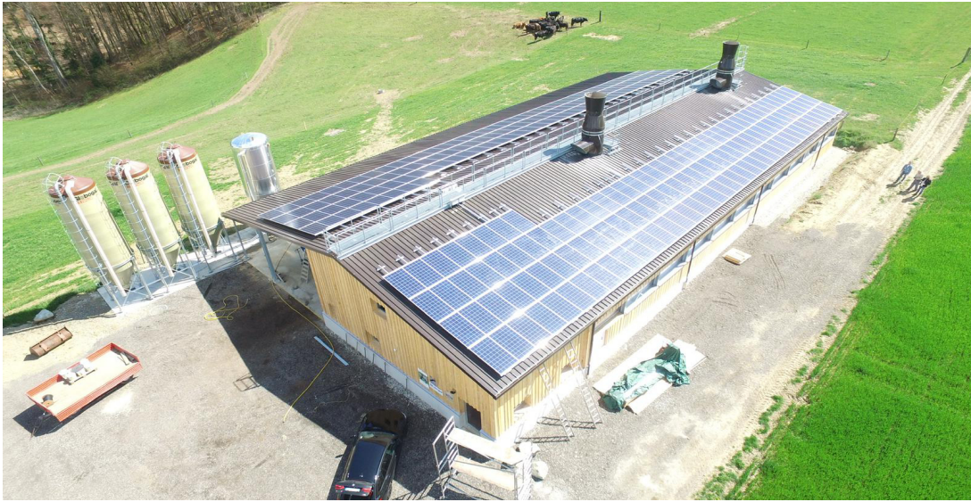
Le poulailler de Micarna à Hellsau (BE): Entre les modules du système photovoltaïque (70 kWp), on peut voir les deux échangeurs de chaleur tubulaires, à gauche derrière le bâtiment, trois silos d'alimentation et l'accumulateur de chaleur. Pour la pompe à chaleur, 2800 m de conduites de saumure ont été posées dans le sol autour du poulailler. Photo: rapport final de l'OFEN
