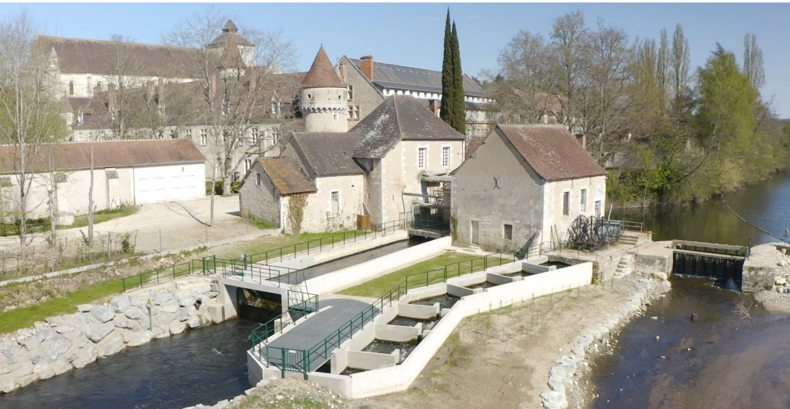
L'aménagement hydraulique de l'Abbaye de FONTGOMBAULT, équipé d'une turbine VLH, permettant à la fois l'autoconsommation et l'injection sur le réseau depuis avril 2021 (Photo : MJ2 Technologies)
