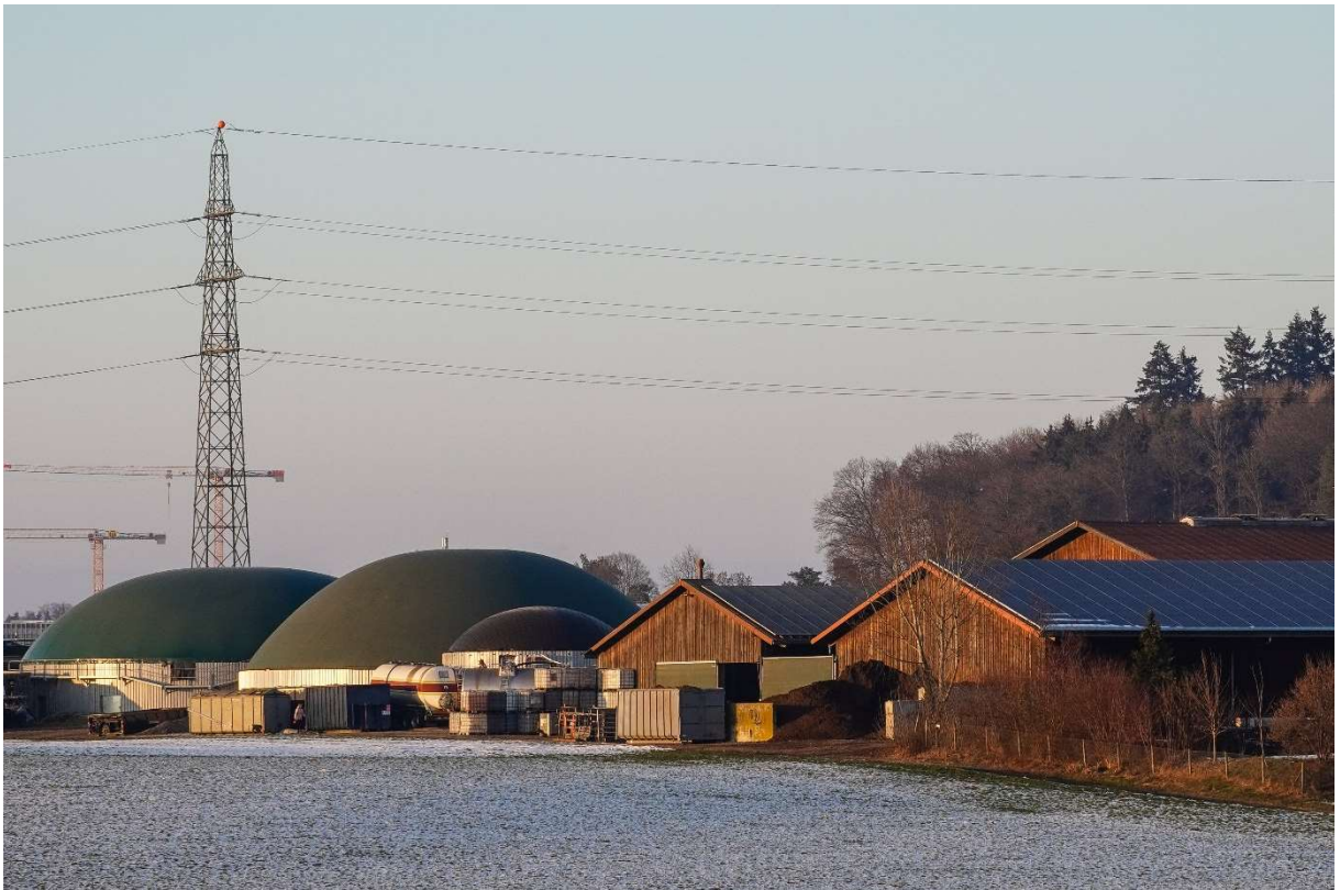
Installation photovoltaïque et de biogaz dans la région de Berne
