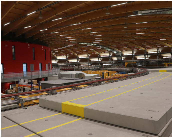
Regard sur « La Source de Lumière Suisse » (SLS) à l'Institut Paul Scherrer à Villigen, en Argovie: sous les dalles de béton se trouve le tunnel circulaire avec l'anneau d'accélération (marquage jaune). Les électrons y sont en orbite et émettent une lumière synchrotron qui peut être utilisée pour diverses expériences. Photo: B. Vogel
