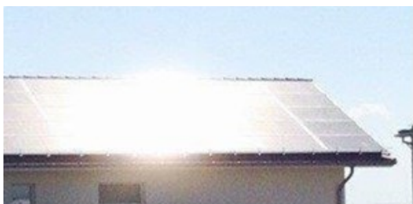
Illustration 7: Effet d'éblouissement d'une toiture inclinée. L'élargissement du faisceau est nettement visible, reconnaissable au fait qu'un phénomène lumineux étalé est perceptible au lieu de l'image directe du soleil.
