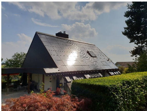
Illustration 8: Surface de toiture avant la rénovation
