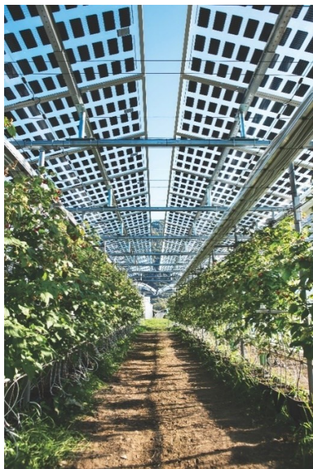
Installation agrivoltaïque située au-dessus d'une plantation de framboises; installation expérimentale, Conthey, © Insolight
