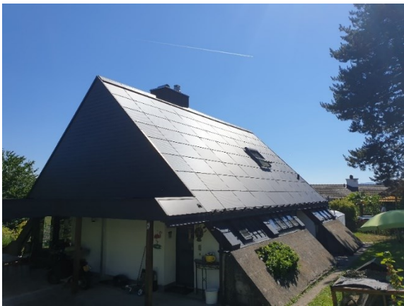
Illustration 10: Surface de toiture après la rénovation
