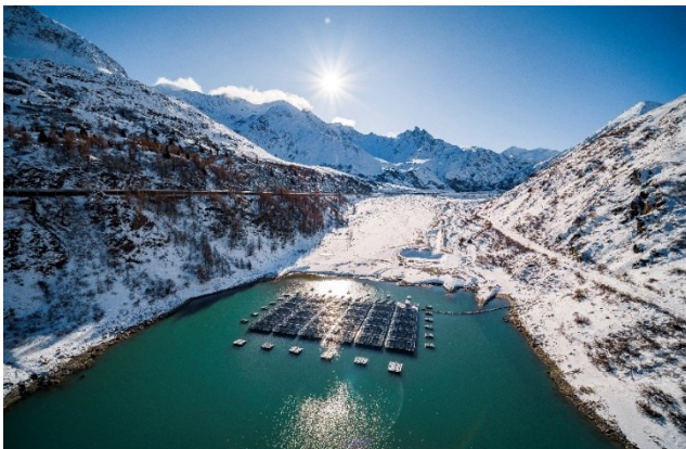
© Romande Energie, installations photovoltaïques sur un plan d'eau artificiel (lac de barrage - Lac des Toules)
