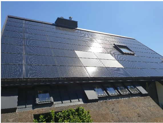
Illustration 9: Échantillonnage avec quatre modules non éblouissants
