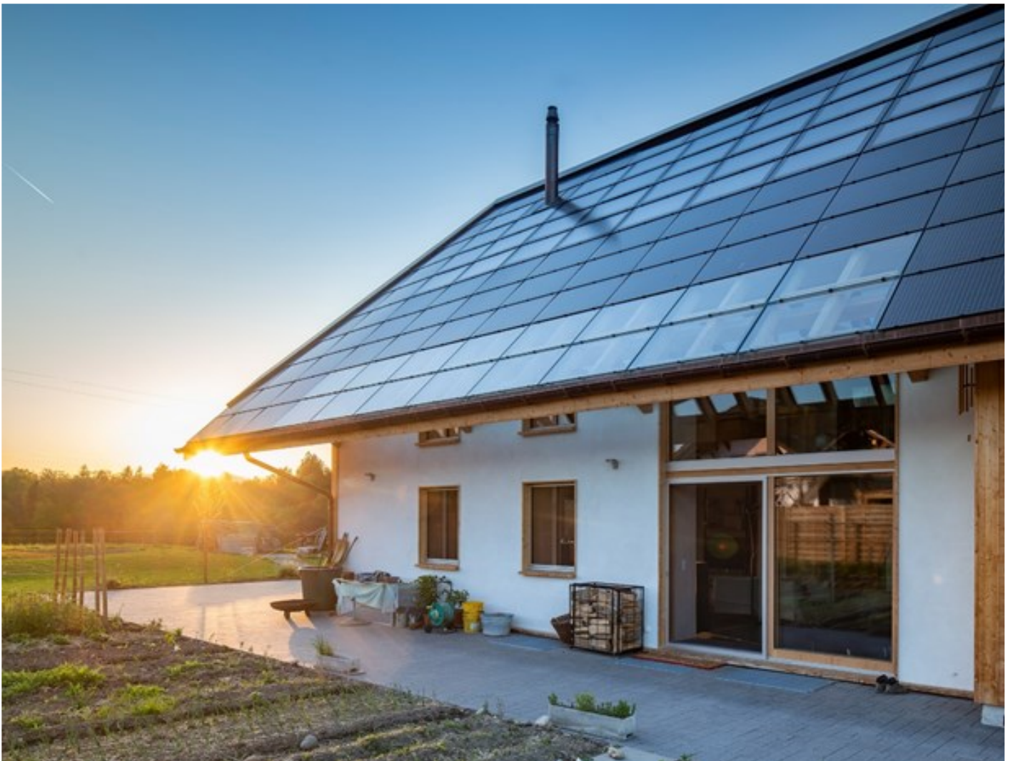
Illustration 1: maison individuelle construite en bottes de paille, Graben BE, © 3S Solar Plus AG / Prix Solaire Suisse 2019
