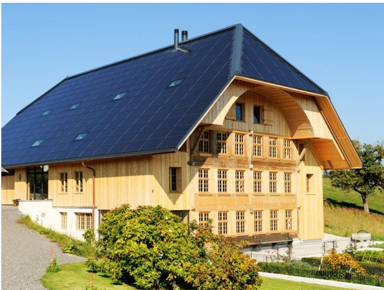
© clevergie ag, maison historique dans l'Emmental, à énergie positive avec installation photovoltaïque entièrement intégrée, et installation photovoltaïque sur la rabatture, c'est-à-dire la pointe du pignon en croupe ou le triangle de couverture au-dessus de la façade du pignon.
