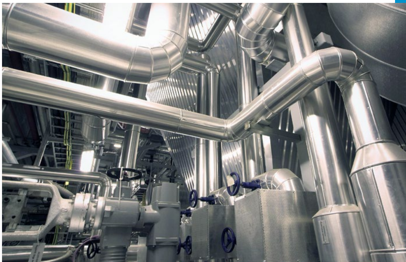
Les procédés technologiques et les pratiques de gestion innovants augmentent l'efficacité énergétique. Les énergies renouvelables sont intégrées dans des installations et sites en réseau et dans toute la chaîne de création de valeur. © Shutterstock
