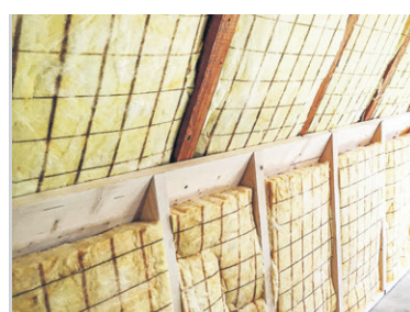
Wer Dach, Wand und Boden eines Gebäudes dämmt, erhält Förderbeiträge.
