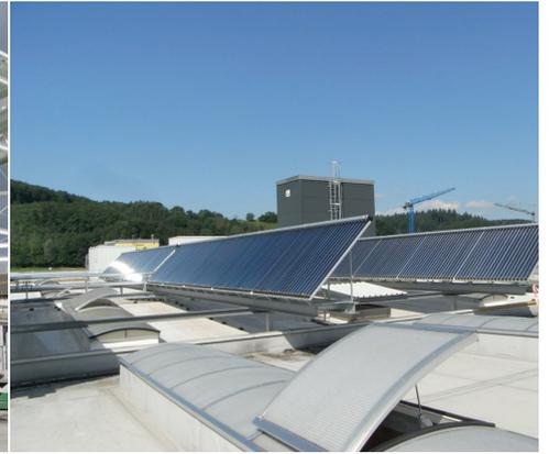
Capteurs à tubes sous vide (sur l'image: Les fabricants de chauffages Zehnder à Gränichen/AG) utilisent les rayonnements direct et diffus pour le chauffage d'un fluide caloporteur (ici: un mélange eau-glycol). Le fluide caloporteur circule dans un tube isolé par le vide. Photo: SPF
