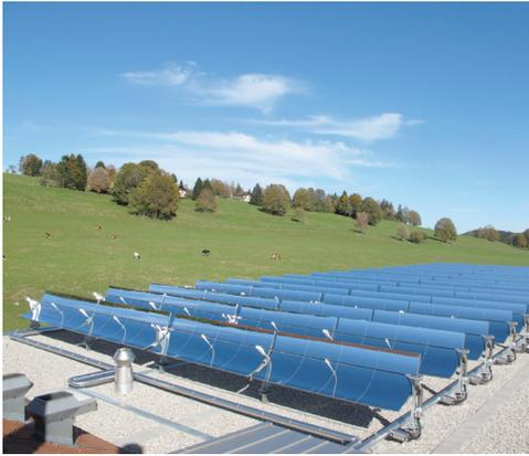
Les capteurs cylindro-paraboliques (sur l'image: Fromagerie de Saignelégier) concentrent le rayonnement solaire sur un tube absorbeur dans lequel circule de l'eau et qui chauffe le fluide caloporteur jusqu'à 112°C. Les capteurs utilisent le rayonnement direct, mais pas le rayonnement diffus. Photo: SPF
