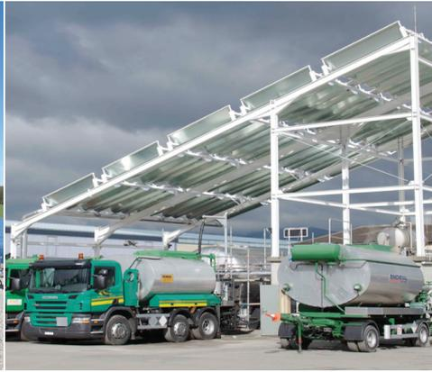
Capteurs plats sous vide (sur l'image: Les entreprises de construction routière Colas à Yverdon-les-bains/VD) utilisent le rayonnement direct et diffus. Ils se différencient des capteurs à tubes sous vide par leur rendement élevé également avec des températures supérieures à 100 - 150°C. Photo: Lesbat/HEIG-VD
