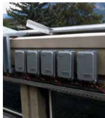
Convertisseurs DC/DC individuels modules photovoltaïques sur le toit de la HES-SO Valais Wallis. Chaque des 45 modules disponibles est connecté au «bus» DC via son propre convertisseur permettant à chaque module d'opérer de manière optimale. L'efficacité des convertisseurs individuels est de 97 à 98 % (source: HES-SO Valais Wallis).
