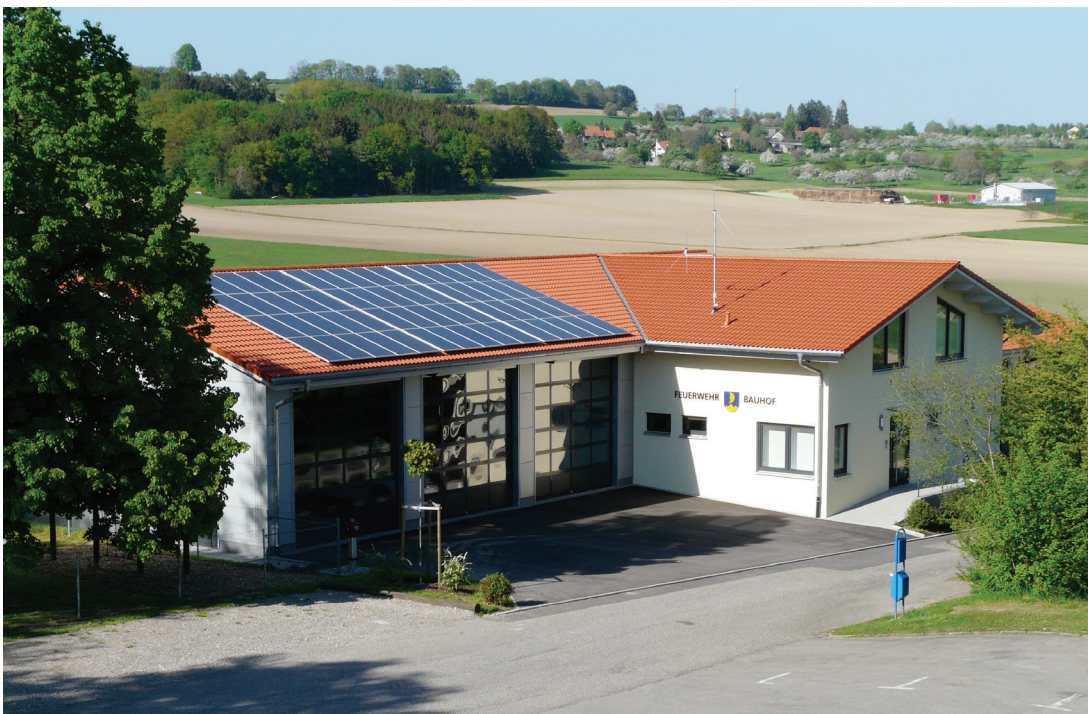
À Dettighofen (Allemagne du sud), l'utilisation du photovoltaïque est fortement développée. La production d'électricité solaire correspond à pratiquement la moitié de la consommation. Image: installation PV sur la caserne des pompiers mise en service en 2017. Photo: commune de Dettighofen
