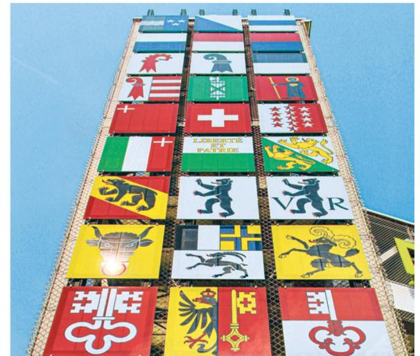
**Imprimé** : ces écussons sont également des modules PV. Plus de 20 modules imprimés numériquement ornent la façade de l'Umwelt Arena Schweiz à Spreitenbach (AG). Les panneaux imprimés atteignent environ 80 % du rendement des modules conventionnels. Photo : Stephen Wittkopf
