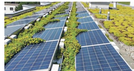
Bien qu'elles soient belles, elles nuisent au rendement énergétique des installations photovoltaïques : des plantes qui créent de l'ombre sur les panneaux solaires. (Photo : Contec)
