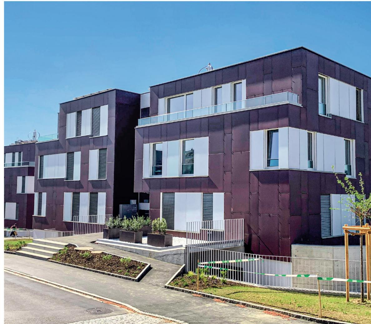
**Blanc** : même si le rendement des panneaux PV noirs est le meilleur, celui des panneaux blancs est bon. Dans ce projet pilote à Männedorf (ZH), toute la façade est active ; les panneaux blancs avec revêtement Solaxess utilisent des ondes lumineuses invisibles. Ce projet sera également présenté à l'Umwelt Arena Schweiz. Photo : Solaxess, architecte : René Schmid
