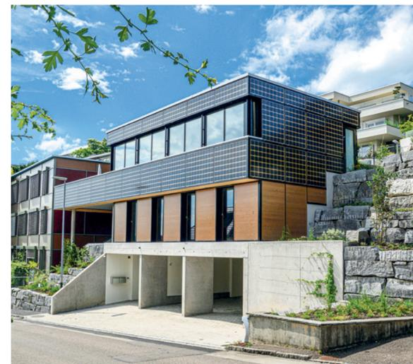
**Bifacial** : le système de façade PV de la maison jumelée PlusEnergy à Wil (SG) utilise à la fois la lumière directe du soleil et la lumière réfléchi par la façade. L'air chauffé entre les panneaux photovoltaïques et la façade est utilisé pour faire fonctionner une pompe à chaleur. Photo : Giuseppe Fent AG
