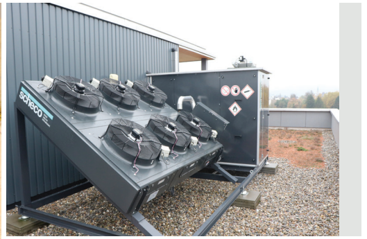
En haut: La pompe à chaleur air/eau (en arrière-plan) avec l'unité externe (évaporateur/condenseur selon le mode d'exploitation) sur le toit de la société 3-Plan Haustechnik AG à Oberwinterthur. Photo: B. Vogel
