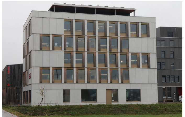
Le bâtiment à usage de bureaux de la société 3-Plan Haustechnik AG: Avec 118 m 2 , l'installation photovoltaïque sur le toit a une surface relativement petite mais produit plus d'électricité que le bâtiment n'en a besoin pour le chauffage, le refroidissement et la ventilation. 95% de la production d'électricité sont consommés sur place. Photo: B. Vogel
