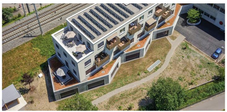
L'accumulateur de glace se trouve au sous-sol de l'immeuble résidentiel et commercial, à côté du parking souterrain. A gauche, entre le bâtiment et l'arbre, se trouve une lucarne carrée qui permet l'accès pour les révisions. Le bâtiment obtient la chaleur des collecteurs installés sur le toit. Photo: EWJR
