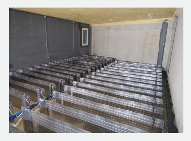
est périodiquement éliminée par le pompage de la saumure chaude (en provenance des collecteurs ou du stockage tampon) à travers les échangeurs de chaleur lorsque la pompe à chaleur est arrêtée. Les plaques de glace se détachent des échangeurs de chaleur et remontent à la surface de l'eau. Elles y remplissent progressivement l'accumulateur de glace par le haut.
