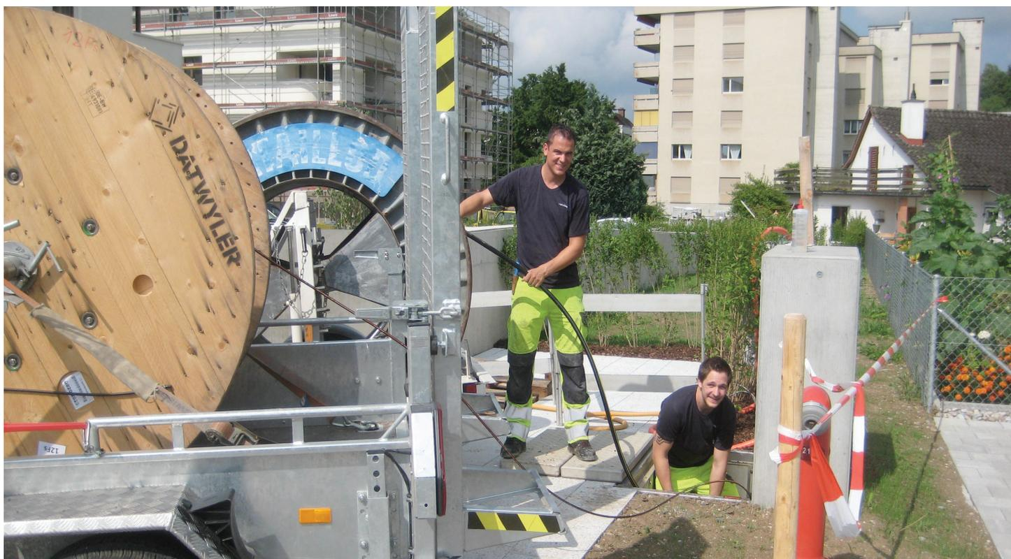
Les fournisseurs d'électricité ont pour but d'approvisionner tous les consommateurs d'électricité conformément à leurs besoins. Sur l'image: mise en place d'un câble basse tension pour la viabilisation d'une nouvelle zone de construction. Photo: Technische Betriebe Weinfelden AG
