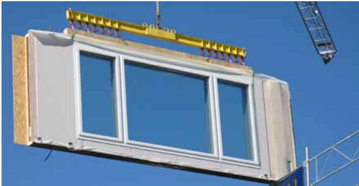
Mehrfamilienhaus-Erneuerung mit vorgefertigten Elementen. Im Projekt «Prefab Retrofit» der Internationalen Energieagentur (IEA) wird unter Schweizer Leitung eine neuartige Lösung für eine effiziente Erneuerung von Mehrfamilienhäusern entwickelt. Die Gebäude werden mittels Laserscanning und Aufnahmen aus der Luft dreidimensional vermessen. Dies erlaubt eine effiziente und massgenaue Vorfertigung der neuen Gebäudehülle in der Fabrik. Die Bauprozesse werden dadurch wesentlich verkürzt. (Empa)
