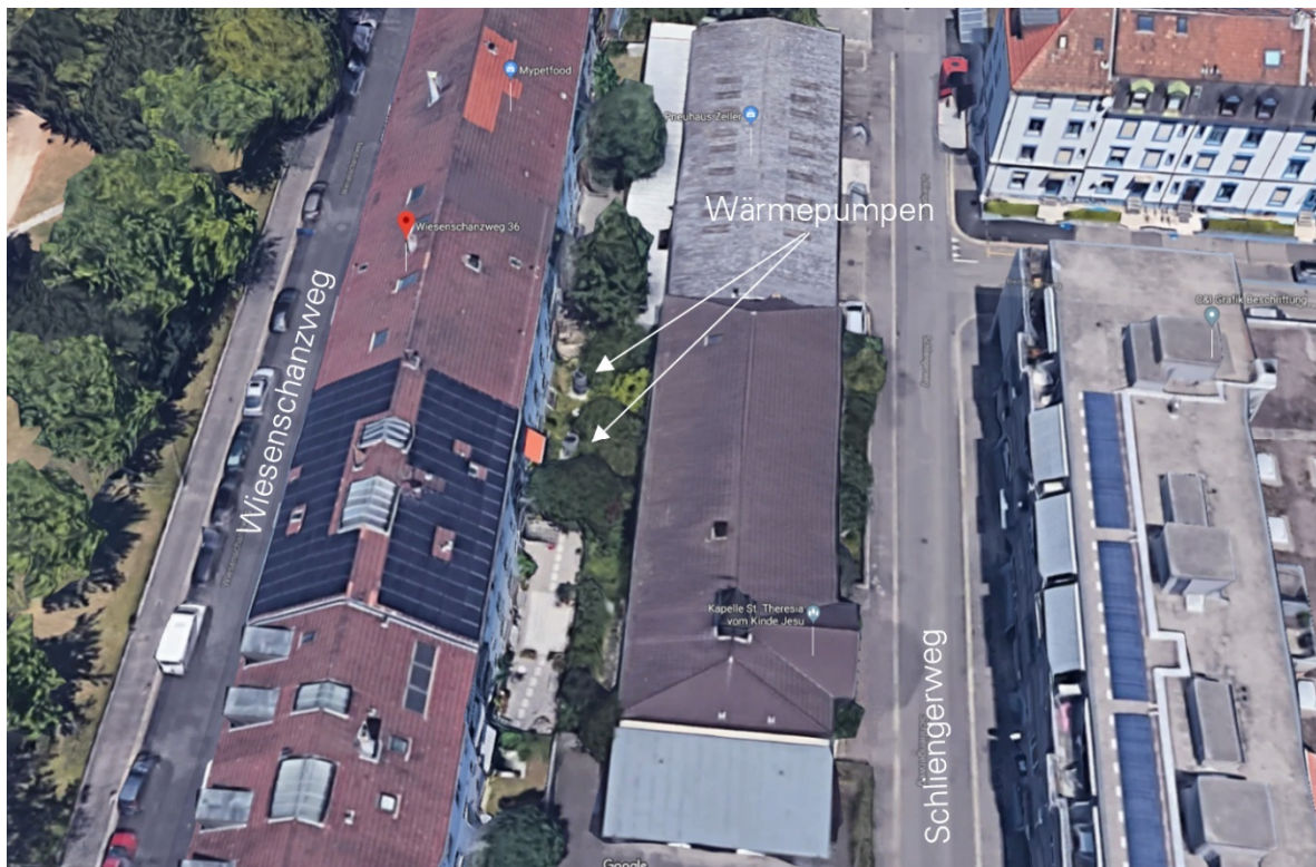
Abbildung 1: Aufstellungsort der beiden Wärmepumpen im Innenhof zwischen Wiesenschanz- und Schliengerweg (Quelle: Google-Maps)
