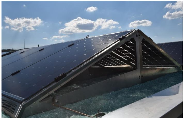
wurde ein Teil der Anlage auf weisses Glasschrott aufgestellt, der andere Teil wurde mit matt eloxierten Aluminiumblechen unterlegt. Der geschätzte Zusatzertrag durch die bifazialen Solarmodule beträgt 5-10 %. Die Maximierung des Ertrags wäre möglich, indem der Systemaufbau mit dem Einsatz lichtdurchlässigerer Solarmodulen, die über grössere Abstände zwischen den Siliziumzellen verfügen, optimiert wird.
