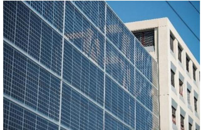
kWh/kWp/a berechnet. D.h. es könnte ein Zusatzertrag durch die bifazialen Solarmodule von ca. 13 % erreicht werden. An einigen Schönwettertagen im Jahr, insbesondere im Frühjahr, wird die Leistungsgrenze der Wechselrichter erreicht.
