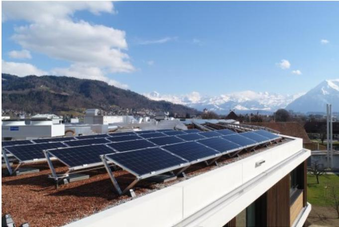
Im Jahr 2018 wurde die 101-kWp-Anlage auf einem neuen Flachdach in Steffisburg (BE) installiert. Dabei wurden 342 SkySlate Bifazialmodule der Firma 3S Solar Plus AG mit jeweils 295 Wp nominaler Modulleistung installiert. Der Neigungswinkel der Module beträgt 20°.
