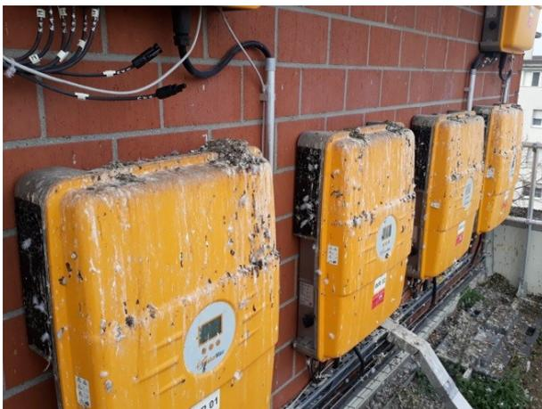
Abbildung 4: Verschmutzte Wechselrichter, Jendra Power AG
