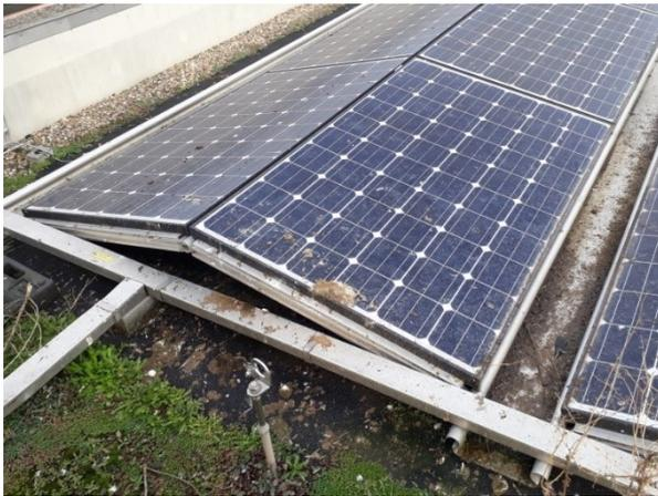
Abbildung 5: Verschmutzte Module, Jendra Power AG
