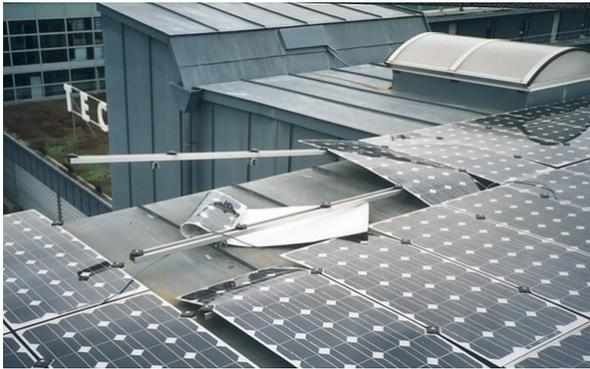
Abbildung 3: Modulschaden nach Sturm, Edisun
