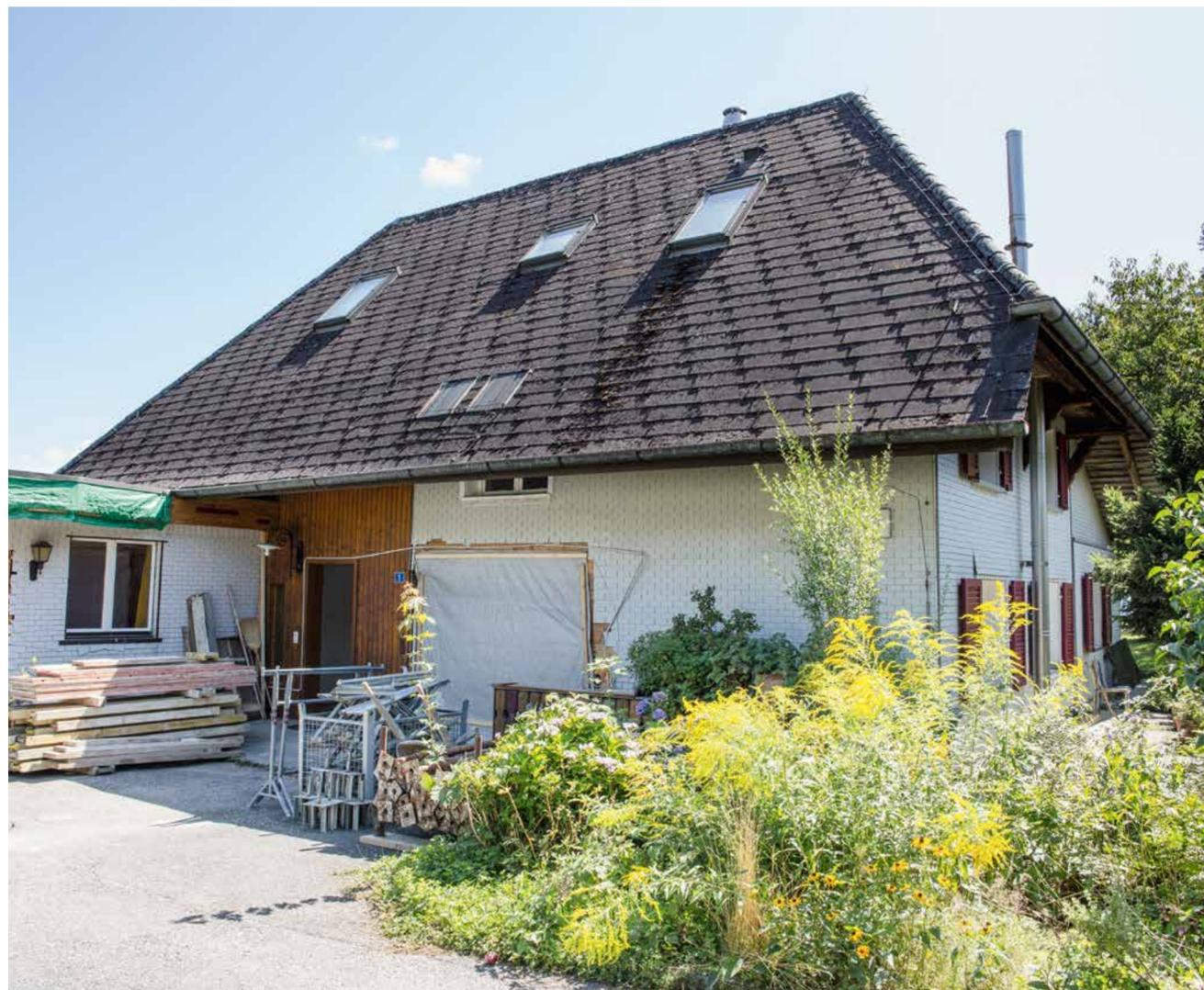
Bis 2021 soll das alte Bauernhaus in Heimenhausen komplett saniert sein – mit neuer Dämmung, Holzheizung, unterstützender Wärmepumpe und Photovoltaikanlage.
