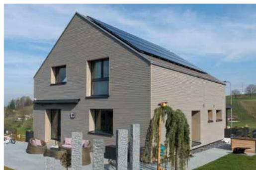
Vorher/Nachher: Dank neuer Dämmung und neuen Fenstern konnte der Energieverbrauch pro Quadratmeter um 75 Prozent gesenkt werden. Das Haus von 1961 hat heute eine Photovoltaikanlage, eine Etage mehr und Minergie-A-Standard.
