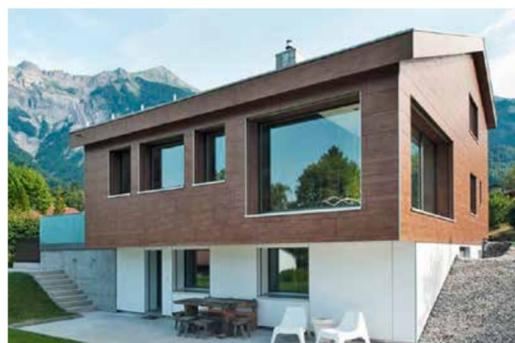
Dieses Haus mit Baujahr 1966 wurde mit einer neuen Dämmung, einer Wärmepumpe, einer Photovoltaik- und einer thermischen Solaranlage ausgestattet. Der Energiebedarf reduzierte sich um 65 Prozent.
