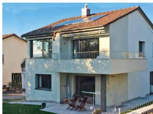
Von Effizienzklasse G auf C: Das 1978 gebaute Einfamilienhaus erhielt eine neue Dämmung sowie neue Fenster.
