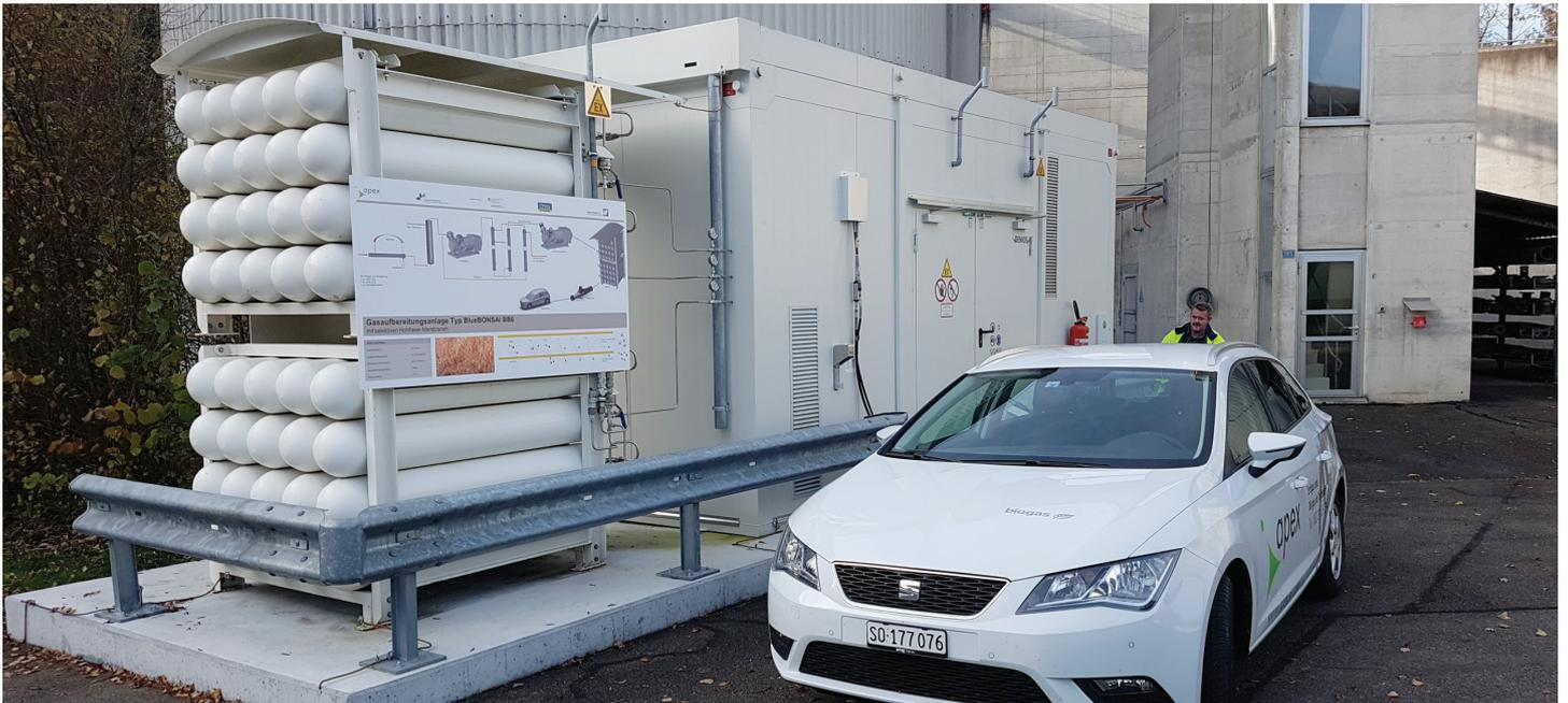
Biomethan-Tankstelle auf dem Gelände der Abwasserreinigungsanlage (ARA) in Schönenwerd (SO): Das Klärgas aus der ARA wird mit einer Membran-Aufbereitungsanlage (untergebracht im Container in der Bildmitte) zu Biomethan «veredelt». Danach steht das Biomethan in 300 bar-Speicherflaschen (links im Bild) für die Betankung von Gasautos bereit. Foto: Apex
