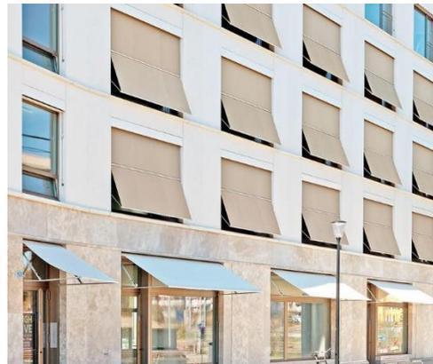
Abbildung 7: Gelenkmarkisen mit/ohne seitlichen Sonnenschutz (Schenker Storen)
