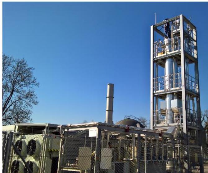
**Abb. 4:** Prozesskühler, Flüssigkeitsskid und Reaktorturm
