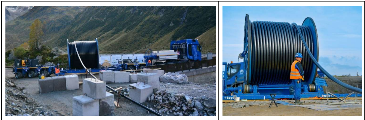
Abbildung 10: Kabelverlegung ab Transportfahrzeug oder abgeladener Kabeltrommel (Quelle: Fa. Wassermann Kabeltechnik)
