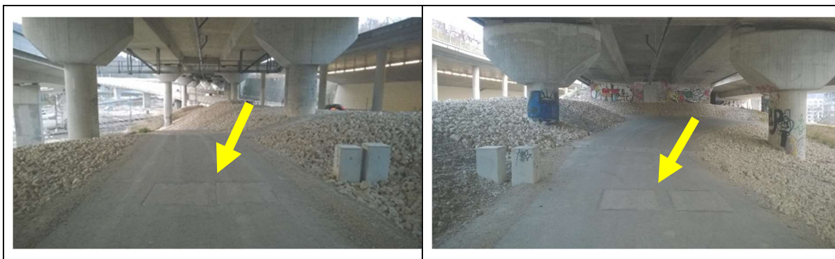
Abbildung 6: Vorbereiteter 380/200 kV-Leitungszug Wollishofen-Uetlibergtunnel mit Dienststrasse und Muffenschacht unter einer der Brücken der Autobahnver-zweigung Zürich Süd (Pfeile: Deckel der Muffenschächte)
