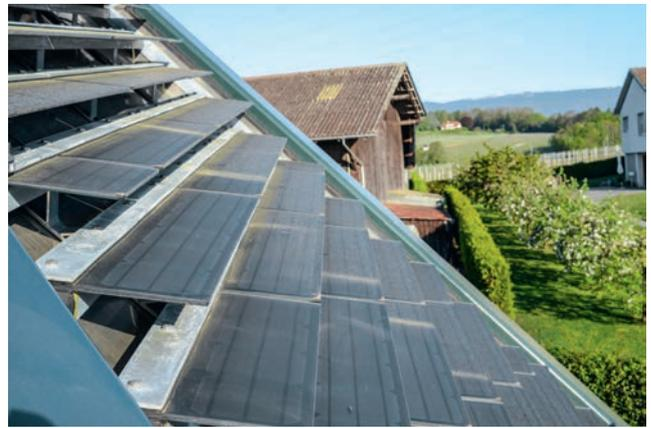
Eine einfache Klemmkonstruktion hält die Photovoltaik-Module.
