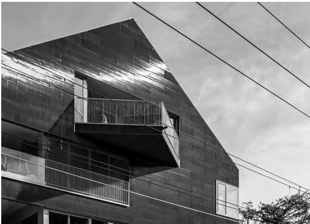
Das Wohnhaus Solaris in Zürich-Wollishofen produziert mit einer neuartigen Fassade Strom.
