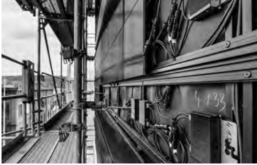
Die Fassadenkonstruktion ist eine Sonderanfertigung der Firma Gasser aus St. Gallen: Die Glaselemente hängen an Aluminiumschienen und werden mit Imbusschrauben durch die schmalen Fugen fixiert.
