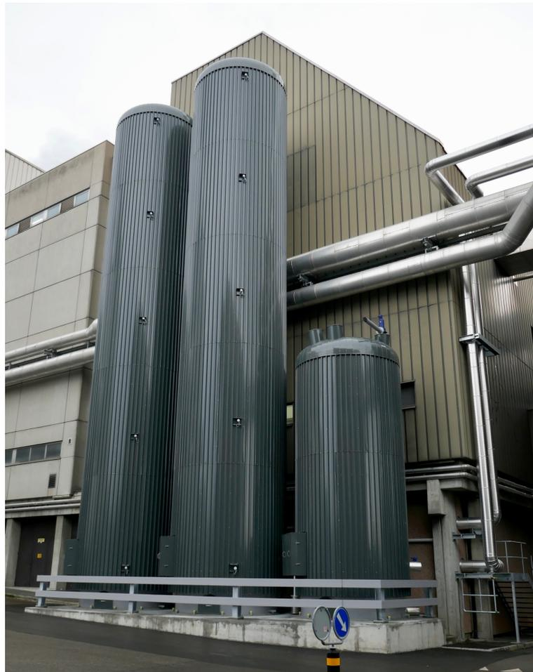
Abbildung: KVA Zuchwil: 2018 ist das erste Jahr Vollbetrieb der neuen Power-to-Heat Anlage für Sekundärregelleistung. Im Bild sind die im Rahmen des Projekts neu gebauten Speicher zu sehen. (Quelle: Rytec AG)
