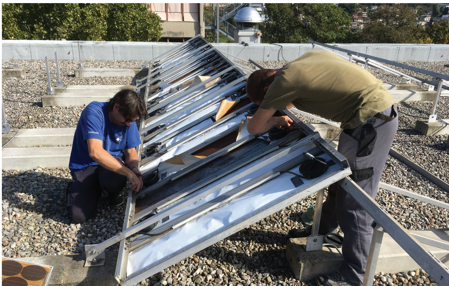
Bis 2017 stand die Photovoltaikanlage TISO-10 auf dem Dach der Aula Magna der Fachhochschule SÜDSCHWEIZ in Canobbio. Dann wurde sie demontiert (Bild), damit SUPSI-Forscher den Zustand der Module nach 35 Betriebsjahren untersuchen konnten. Foto: Schlussbericht TISO 35+
