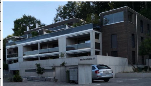
Abbildung 15: Daten des Messobjekts in Wald (links) und Frontansicht des Gebäudes (rechts)
