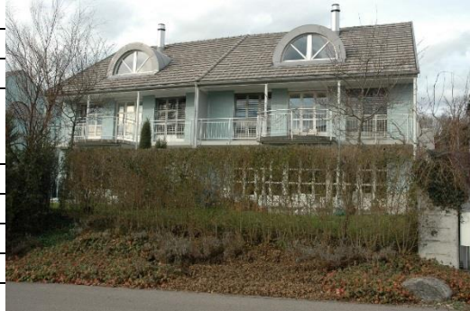
Abbildung 8: Daten des Messobjekts in Uster (links) und Frontansicht des Gebäudes (rechts)
