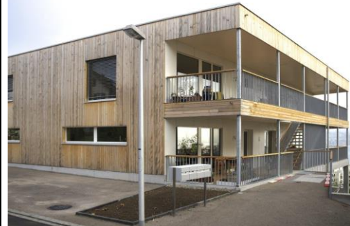
Abbildung 23: Daten des Messobjekts in Horgen (links) und Ansicht des Gebäudes (rechts)
