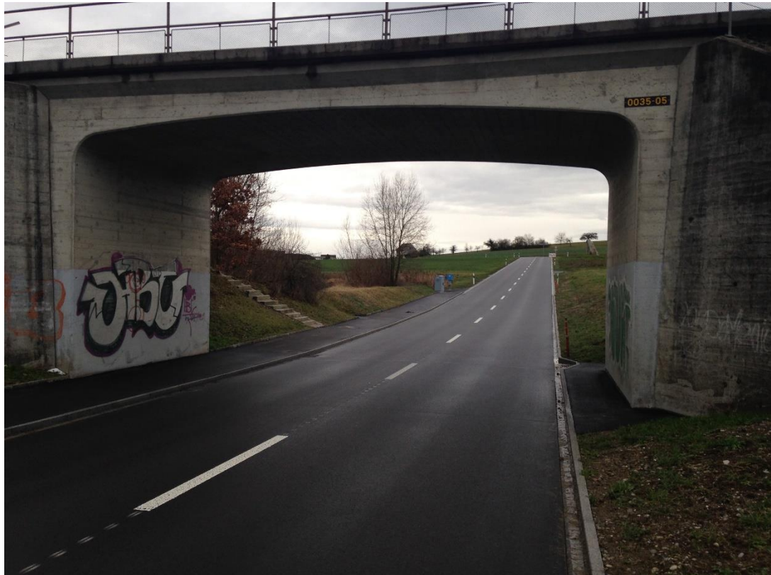
Abbildung 14: Unterquerung Bahnlinie nach Autobahnausfahrt Benken
